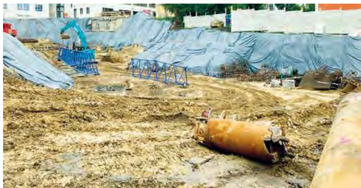
Nach dem Abbruch der Altgebäude wurde die Baugrube ausgehoben.
